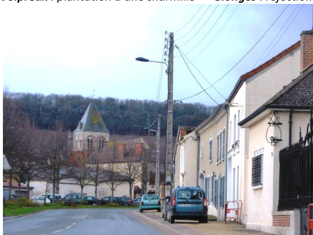
Vertus : Travaux d'enfouissement des réseaux avant
