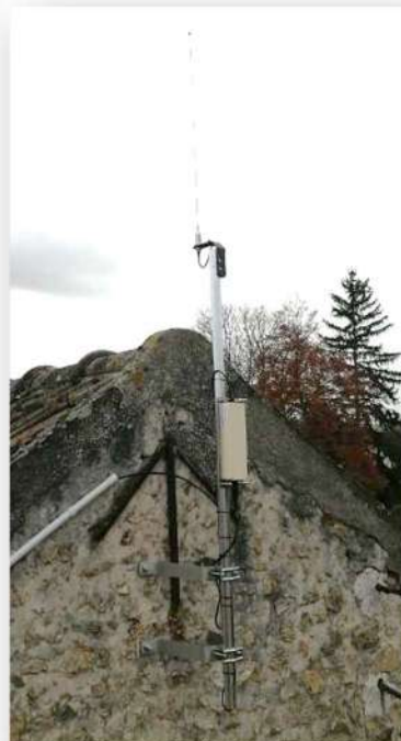
Antenne fouet et modem LAN monté sur un mât HT 2.00 m repris contre la façade pignon
