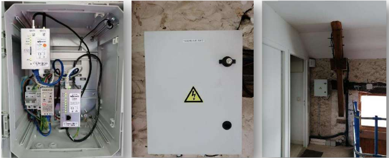
Coffret Concentrateur installé contre le mur au niveau du 1er étage
