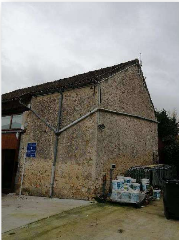
Antenne fouet et modem LAN monté sur un mât HT 2.00 m repris contre la façade pignon
