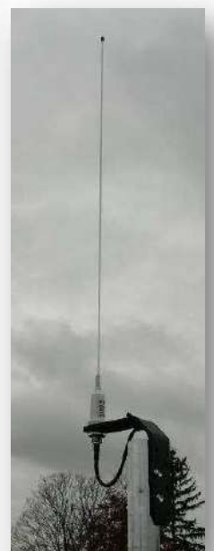
Antenne fouet et modem LAN monté sur un mât HT 2.00 m repris contre la façade pignon
